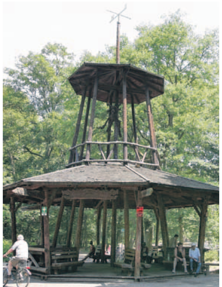
Der Karlstern-Pavillon soll ein neues Dach bekommen. Für Arbeiten wie diese hofft der Förderverein „Freunde des Karlstern“ auf städtische Zuschüsse. BILD: DI
